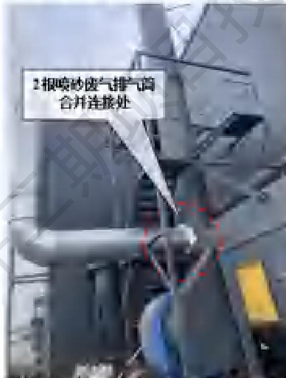
图 3.1-7 喷砂废气排气筒现状图（2 根喷砂废气排气筒中的一根已封堵，并连接到另一根排气筒中排放）
